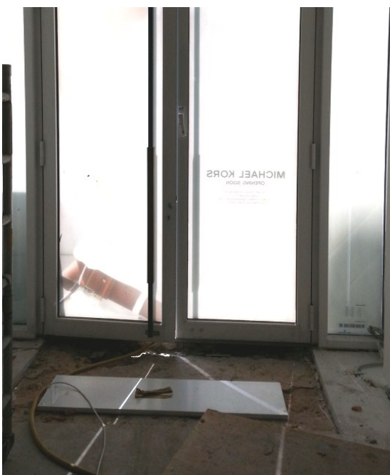
Floor Guard Antenne vor dem Vergießen
